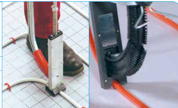
Fixation du tube sur les panneaux isolants par agrafeuse.
