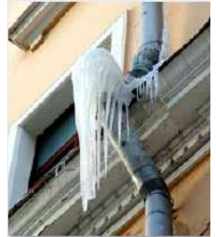
Fig. 2-14 Tuberías heladas
