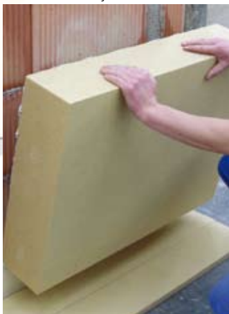
▼ Pose sur maçonnerie
