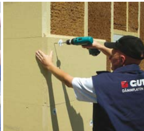
▼ Pose sur montants en bois
