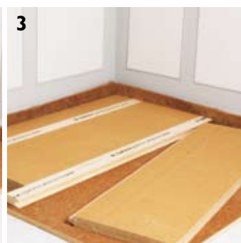
GUTEX Thermosafe-nf avec baguette de pose sur un plancher massif
